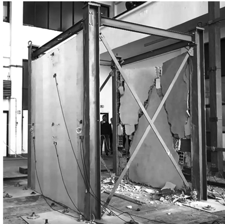
Abbildung 4-42: Einsturz der unverstärkten Wand während Test 16
