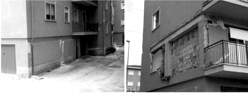
Abbildung 3-2: Out-of-plane Versagensfälle nach dem L'Aquila Erdbeben (Braga et al. [19]): Out-of-plane mit overturning
