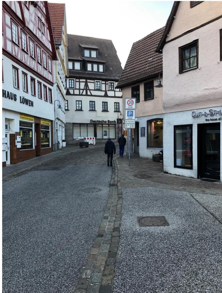
Abbildung 31: Fahrbahnbelagwechsel im Altstadtbereich (eigene Aufnahme)
