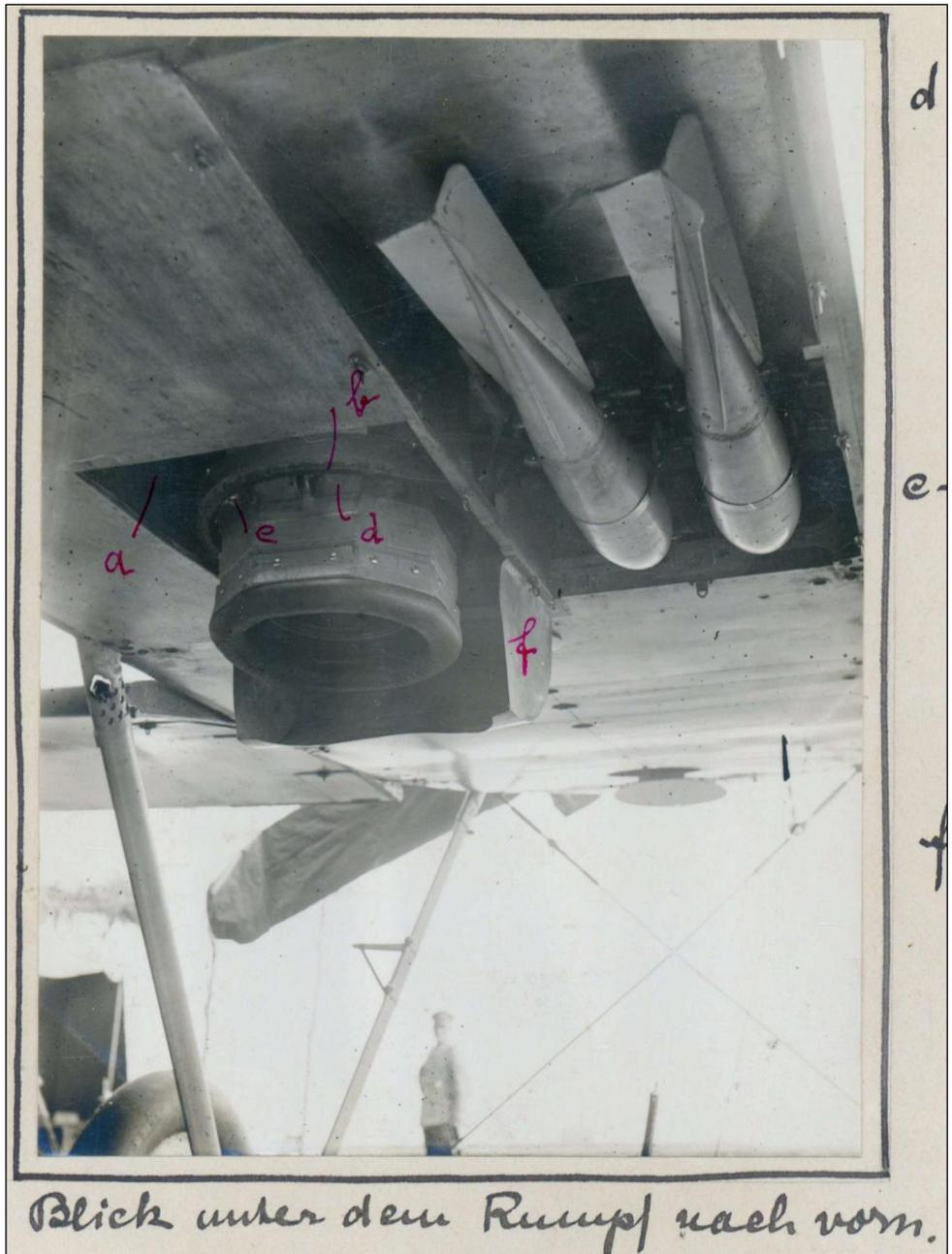
Abbildung 13: Einbau einer Luftbildkamera F.K. III mit 70 cm Brennweite (II)
