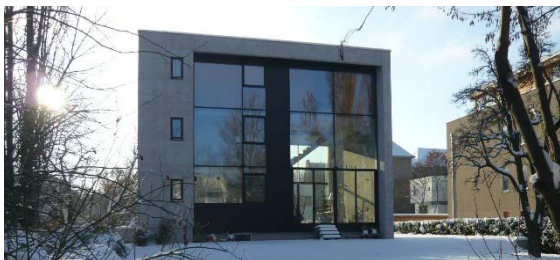
Abb. 7: Einfamilienhaus aus Infraleichtbeton in Berlin von 2007 (Architekten A. Schlaich und C. Bonnen)
