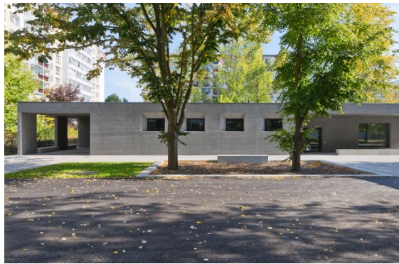
Abb. 8: Jugendfreizeiteinrichtung „Betonoase“ aus Infraleichtbeton von 2018 (Gruber und Popp Architekten)
