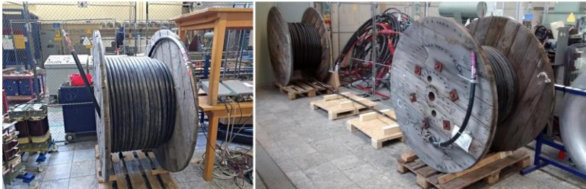
Abb. 157: Mittelspannungskabel auf einer (links) und zwei (rechts) Kabeltrommeln
