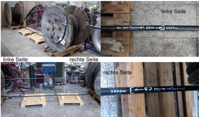
Abb. 154: Mittelspannungskabel auf zwei Trommeln aufgeteilt und mit einem ca. 3 m langen Mittelstück zur Montage einer Wärmequelle
