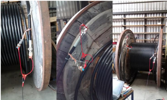
Abb. 122: Einfache Messankopplung des Mittelspannungskabels über anschraubbare Kabelklemmen sowie Laborkabel und Adapter
