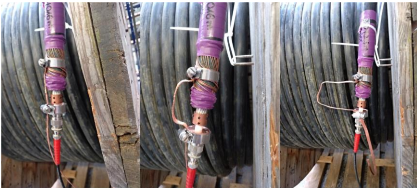
Abb. 131: Untersuchung einer sich ausbildenden Schirmschleife durch den Messadapter und das Schirmgeflecht an dem ca. 136 m langen Mittelspannungskabel
