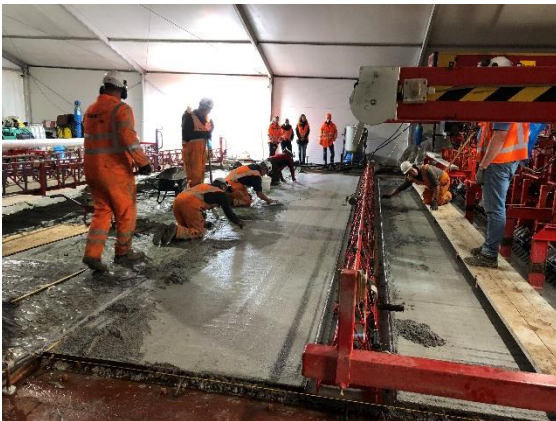
Abb. 20: Maschineller Einbau Fahrbahn-Spezialbeton in Wetterschutzzelt, Rheinbrücke Maxau [KREBS+KIEFER]
