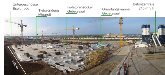
Abb. 15: Baustelleneinrichtung mit Betonzentrale (2013) [KREBS+KIEFER]
