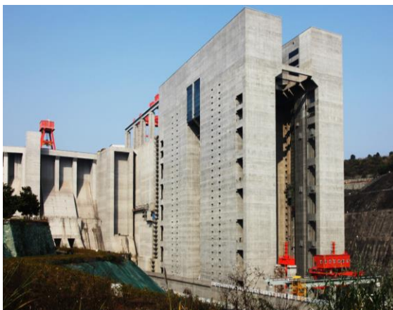
Abb. 2: Schiffshebewerk am Drei-Schluchten-Staudamm, China [5]
