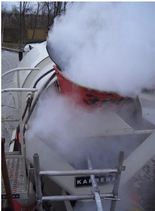
Abb. 4: Kühlung von Frischbeton im Fahrmischer
