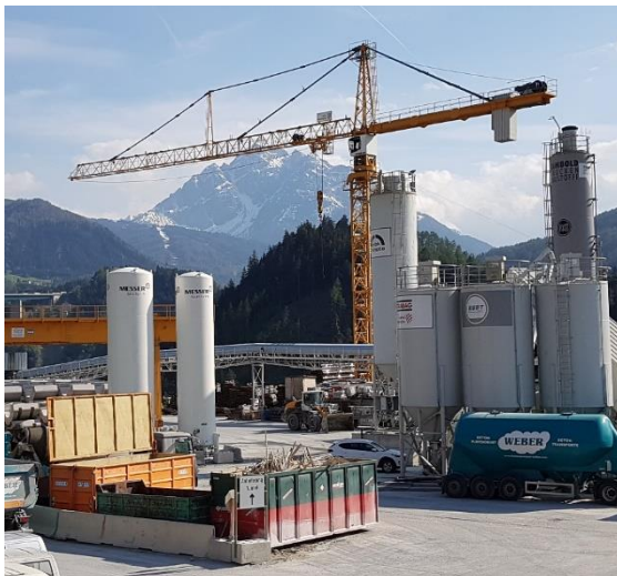
Abb. 1: Tunnelbaustelle mit aktiver Kühlung
