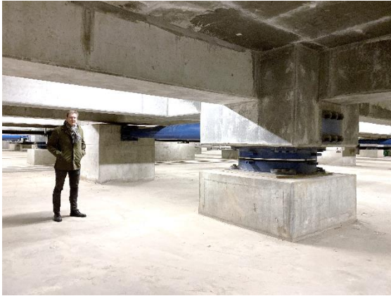
Abb. 13: Sockel für seismische Isolierung [KREBS+KIEFER]
