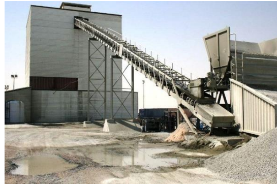
Abb. 5: Konzeption und Ausführung einer Kühlung der groben Gesteinskörnung im Hochsilo einer Betonmischanlage der Firma Mobilbaustoffe Katar in Zusammenarbeit mit der Firma Keckeis
