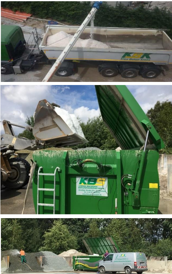
Abb. 6: Vorkühlung der Gesteinskörnung auf Halde mittels Wasserkühlung durch Eisflakes der Firma Krebs Beton
