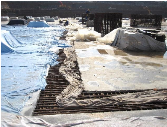
Abb. 19: Nachbehandlung und Schwindgassen Bodenplatte Gebetssaal [KREBS+KIEFER]
