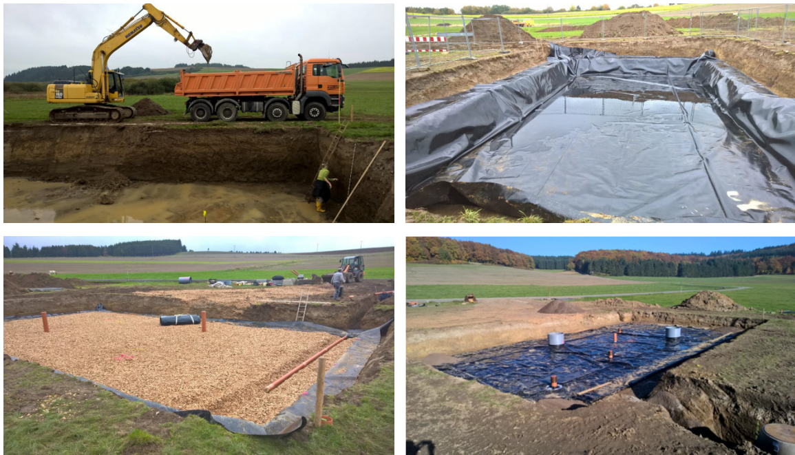
Abbildung 9: Bilder von der Errichtung der Umweltdenitrifikationsanlage an der Drainage D7. Die ausgehobene Fläche von 1,20 m Tiefe (links oben) wurde zuerst mit einer Folie ausgekleidet (rechts oben), danach mit Holzhackschnitzeln befüllt (links unten) und abschließend wieder mit einer Folie zugedeckt (rechts unten) (Fotos: Christian Schulz, SWT Schulz Wassertechnik).
