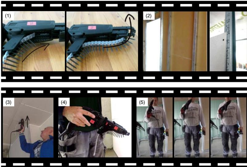
Abbildung 27: Teilszenen aus dem Basis-Trainingsvideo: (1) Einziehen der Magazinstreifen (2) Montage von Gipskartonplatten (3) Verwendung von Trockenbauschraubern (4) einnehmen der richtigen Handposition (5) Prüfung der Gewichtsverteilung<sup>241</sup>
