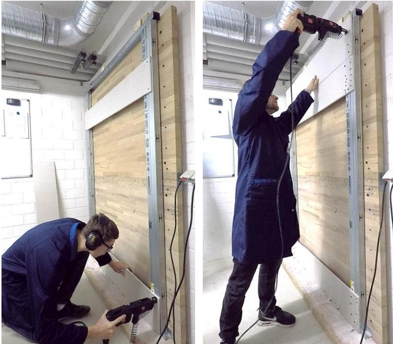
Abbildung 29 Montage von Gipskartonplatten auf CW-Profilen im Power-Tool Test-center des KIT<sup>245</sup>
