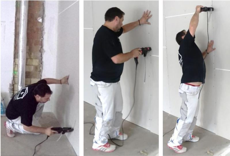
Abbildung 26: Teilaktivitäten der Anwendung „Befestigen von Gipskartonplatten“<sup>240</sup>
