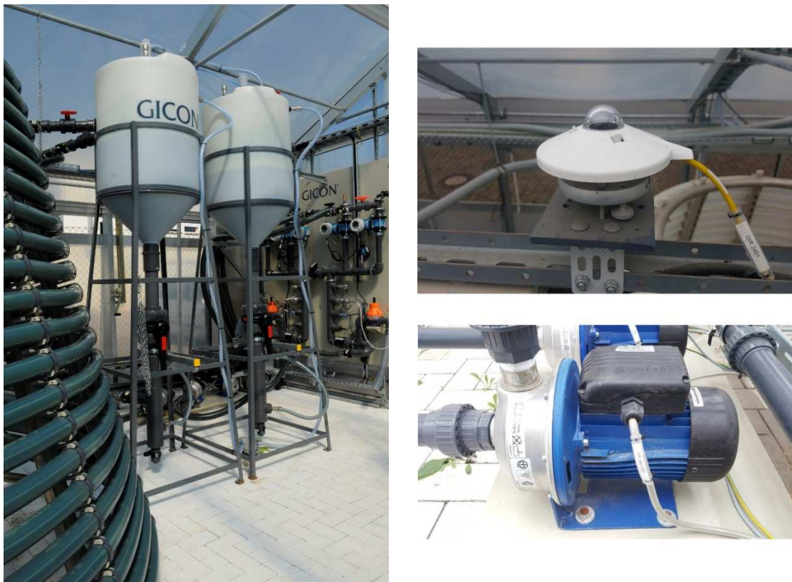
Abbildung 4-2 - Darstellung der Anlagenperipherie mit Mischbehälter (1 Hochbehälter je Teilanlage) sowie Sensor- und Verteilerstation (links) oben rechts: Pyranometer (Kipp & Zonen CMP3) zur Erfassung der Globalstrahlung unten rechts: Kreiselpumpe zum Umwälzen der Mikroalgensuspension (Fa. Lowara bzw. Linn 0,37 bis 0,55 kW als Modell CEA und CO)
