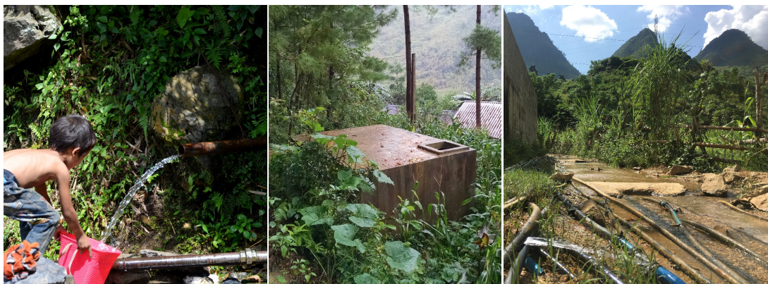
Abbildung 6.9: Wasserentnahme aus gekappter Leitung (links), öffentlicher Wasserspeicher (Mitte) und marodes Schlauchsystem in Siedlung (rechts)
