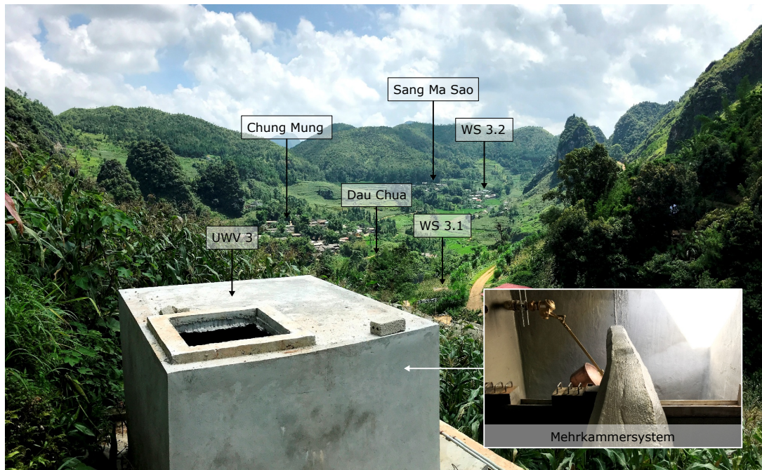
Abbildung 7.15: Bau des untergeordneten Wasserverteilers UWV 3 oberhalb der Siedlung Dau Chua
