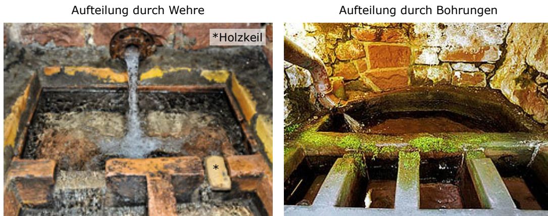
Abbildung 3.9: Wasserverteiler Heidelberg mit Wehr und Bohrung als Beckenübergang (Fotos: Fritz Hartmann, Brunnenwart Heidelberg)
