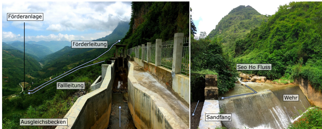
Abbildung 7.2: Wasserbauliche Infrastruktur der Wasserkraftanlage resp. des Wasserfördersystems
