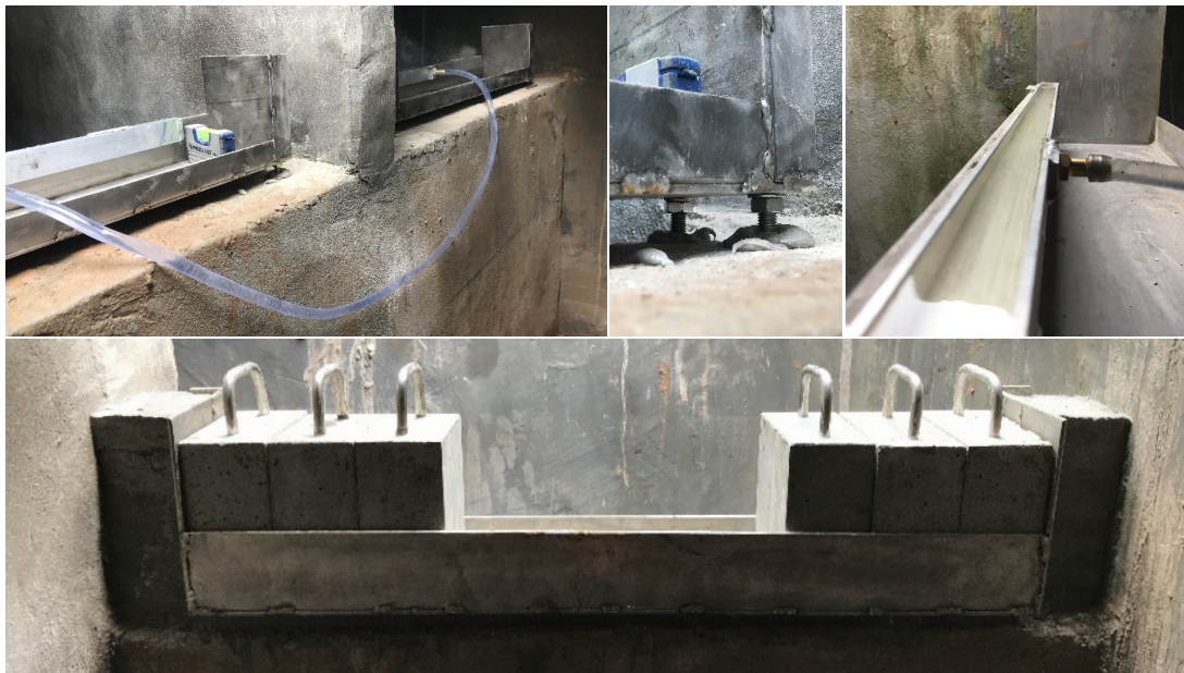
Abbildung 7.11: Installation des Wehrüberfallsystems mit Schlauch- und Wasserwaage
