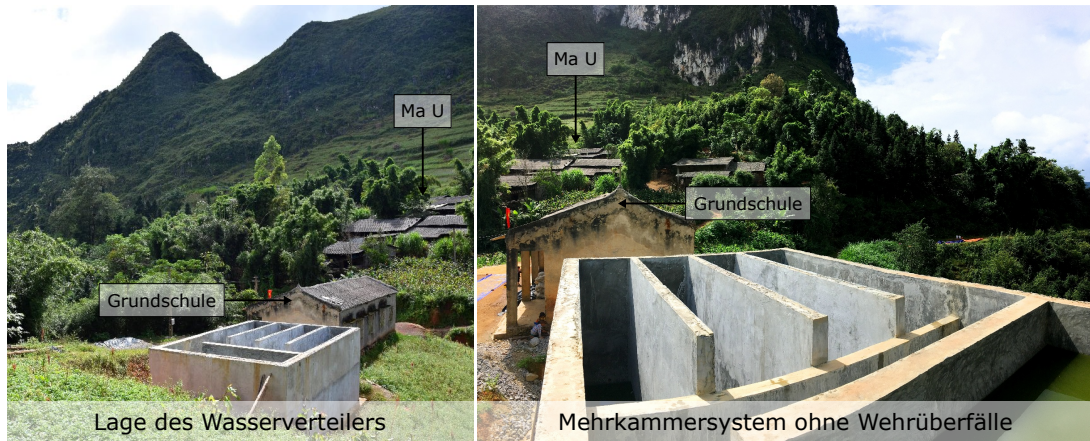
Abbildung 7.13: Bau des übergeordneten Wasserverteilers in der Siedlung Ma U
