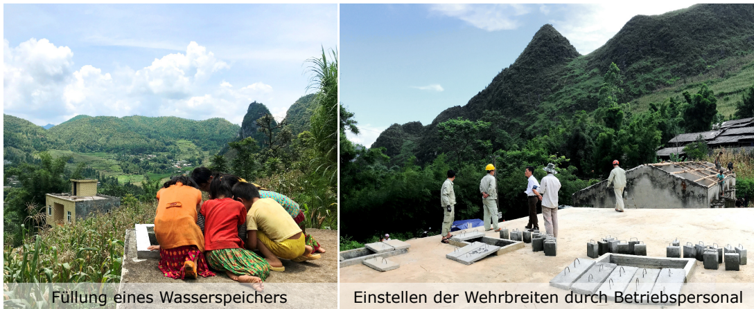
Abbildung 7.28: Interessierte Kinder bei der Füllung eines Wasserspeichers und Betriebspersonal beim Einstellen der Wehrrbreiten im übergeordneten Wasserverteiler
