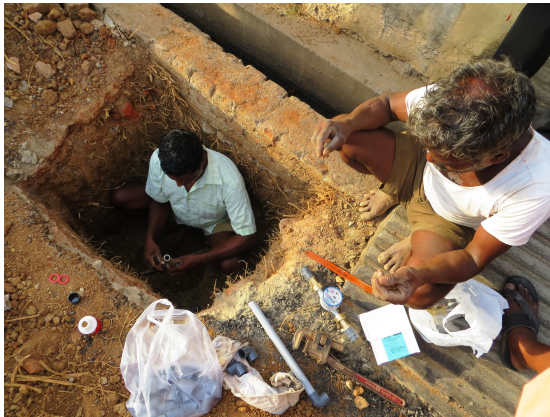
Abbildung 6.11: Installation eines Wasserzählers
