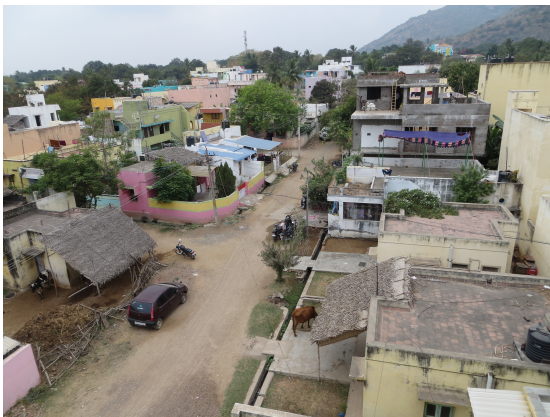
Abbildung 6.2: Bebauung im Pilotgebiet
