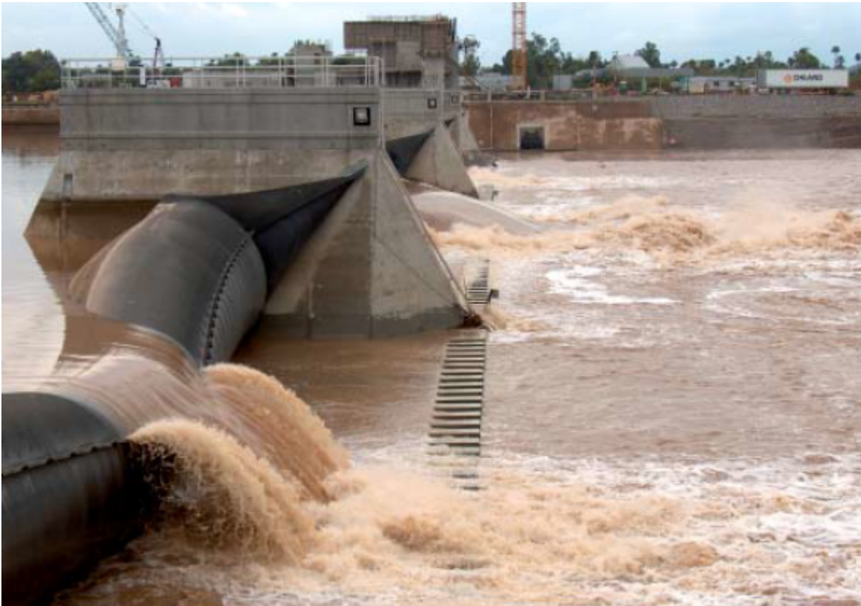
Abbildung 14: Schlauchwehr am Tempe Town Lake, USA, Arizona (Gebhardt, 2008)
