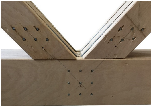
Bild 1-1: Fachwerkknoten mit Stahlblech-Holz-Verbindung.
