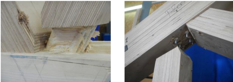
Bild 5-53: Beobachtete Versagensmechanismen von Strahm [50] bei Versuchen an Fachwerkknoten: links : Blockscheren, rechts : Zugversagen der Gewindestangen.
