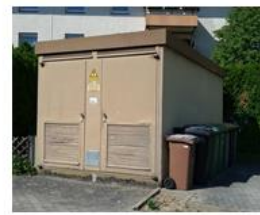
Ortsnetztransformator
