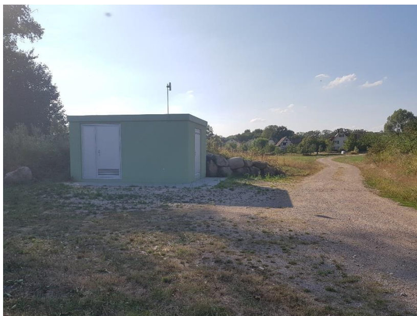
Bild 12: Batteriestation In der Witstung
