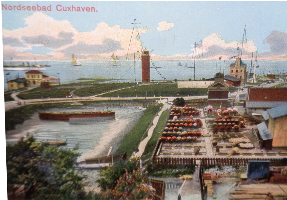
Abbildung 37a: Die „kleine Brücke“ über die Einfahrt zum Ewerhafen (Piepers Loch) 27
