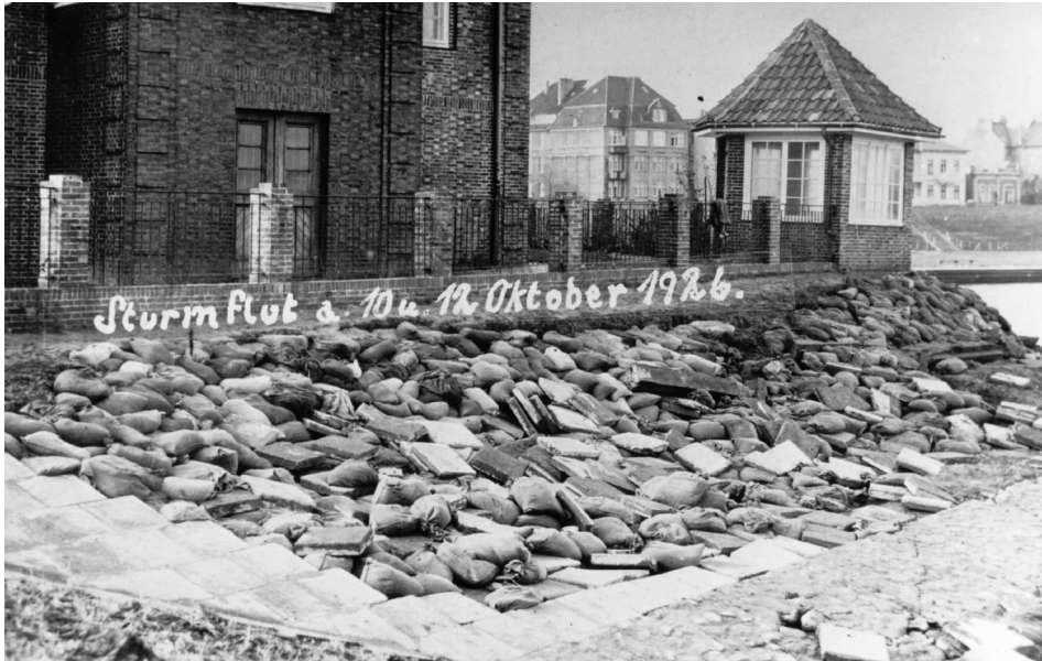
Abbildung 74: Sturmflutschäden beim Haus Seefahrt 1926 52
