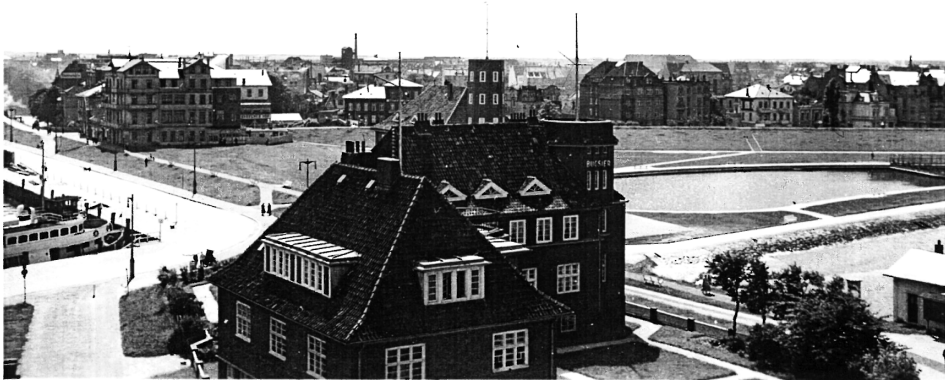
Abbildung 47: Seefunkantennenanlagen auf den Dächern bzw. Türmen des Lotsenhauses, des Bugsierhauses und des Hauses Seefahrt Mitte der 1920er Jahre 78
