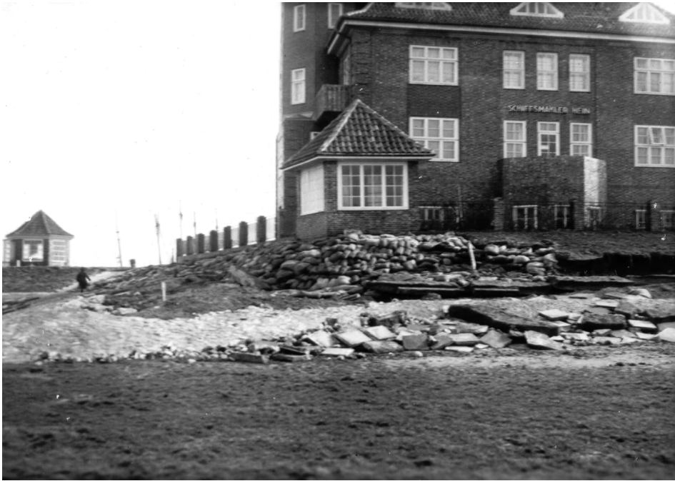
Abbildung 76: Firmensignet „Schiffsmakler Hein“ an der Gebäude-Ostseite des Hauses Seefahrt im Oktober 1926 nach der Sturmflut 63
