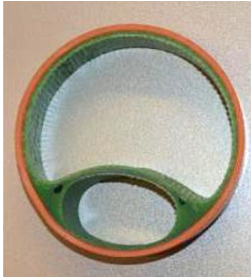
Abbildung 8 Trennung im Bestandsrohr
