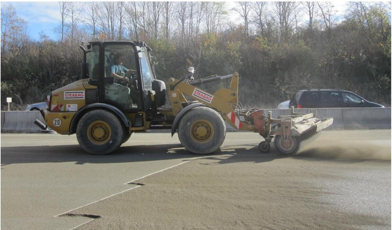
Abb. 4: Entfernen des Oberflächenmörtels durch Ausbürsten
