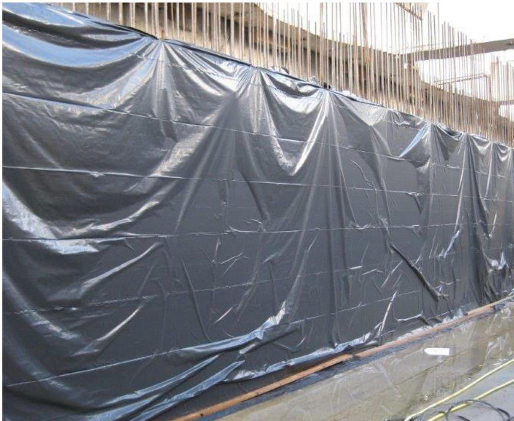
Abb. 5: Mit Folie abgehangene Schleusenammerwand
