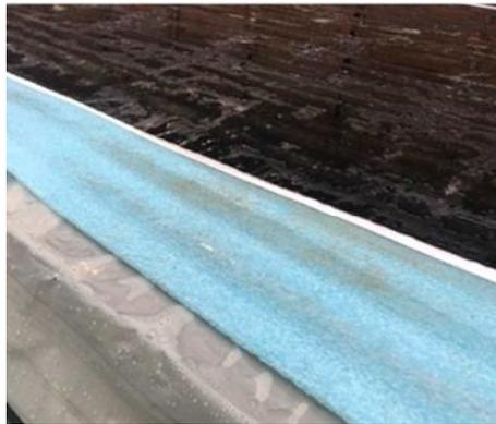
Abb. 7: Nachbehandlung auf einer Deckenplatte (PE-Folie + Wärmedämmmatte + Bautenschutzmatte)
