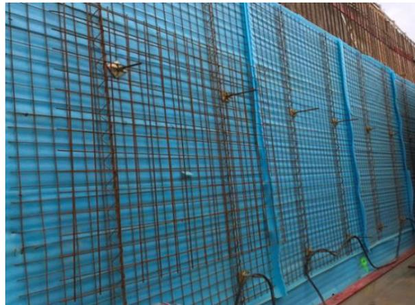
Abb. 5: Nachbehandlungsrahmen mit aufgelegten Wärmedämmplatten
