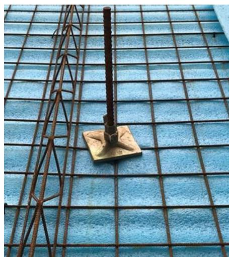
Abb. 6: Nachbehandlungsrahmen mittels Schalungsankern in den vorhandenen Ankerstellen befestigt
