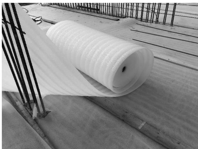
Abb. 1: Beispiel Nachbehandlung einer Bodenplatte bei niedrigen Temperaturen - Folie mit zusätzlicher Wärmedämmmatte
