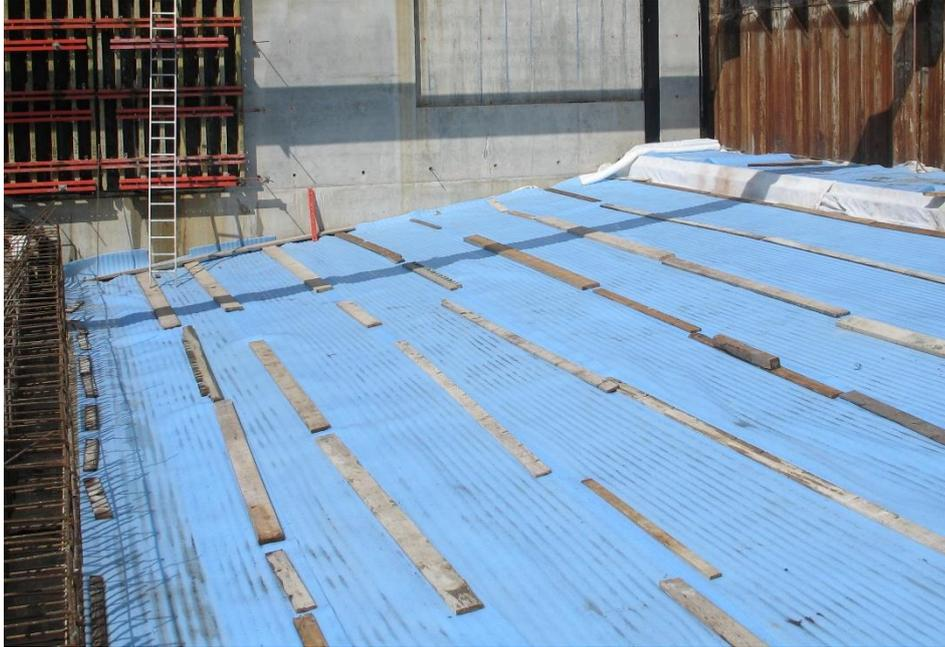
Abb. 8: Wehrsohle mit aufgelegten Bauschutzfolien
