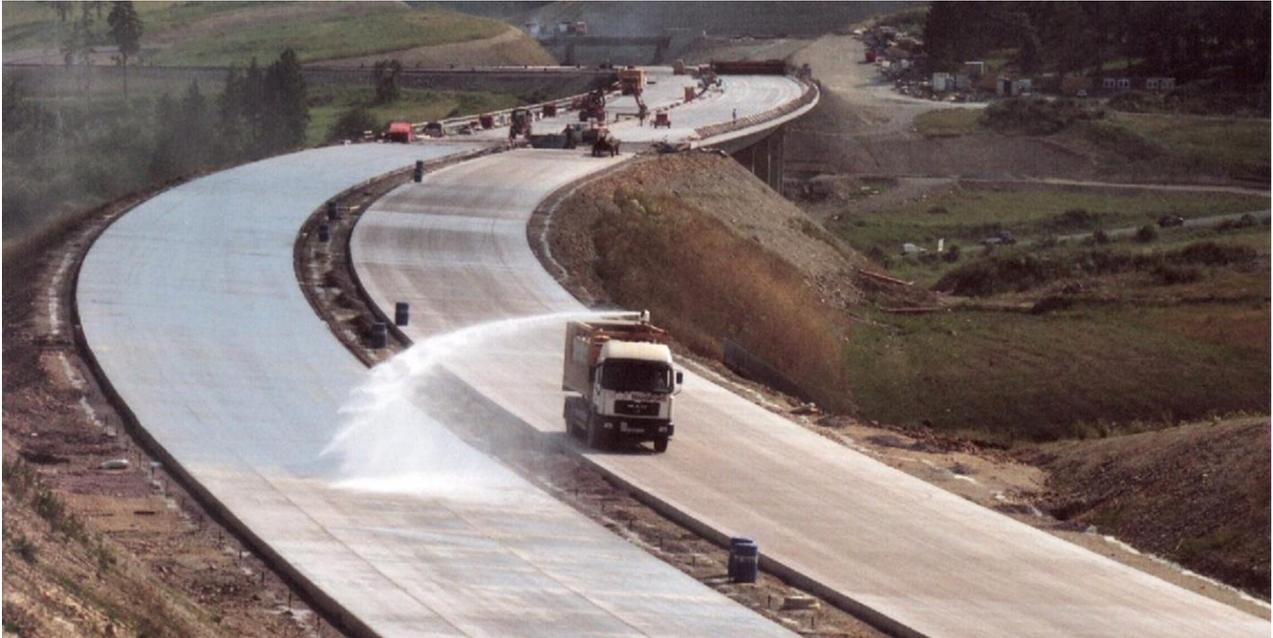
Abb. 1: Schützen der Betondecke durch zusätzliche Nassnachbehandlung
