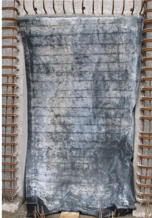
Abb. 10: Abgegangener Längslauf einer Schleuse
