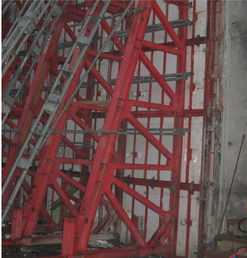
Abb. 1: Isolierte Systemschalung
