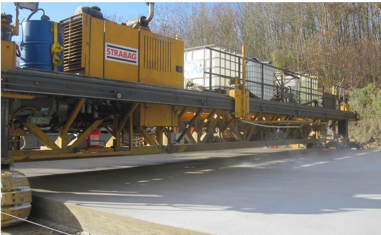
Abb. 2: Aufsprühen eines flüssigen Nachbehandlungsmittels mit einer Arbeitsbühne
