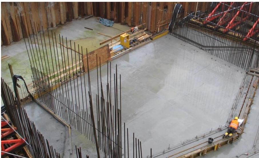
Abb. 3: Geflutete Schleusensole Unterhaupt
