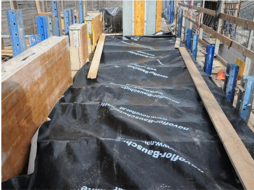
Abb. 2: Mit Bauschutzmatten abgedeckte Schleusenplanie
