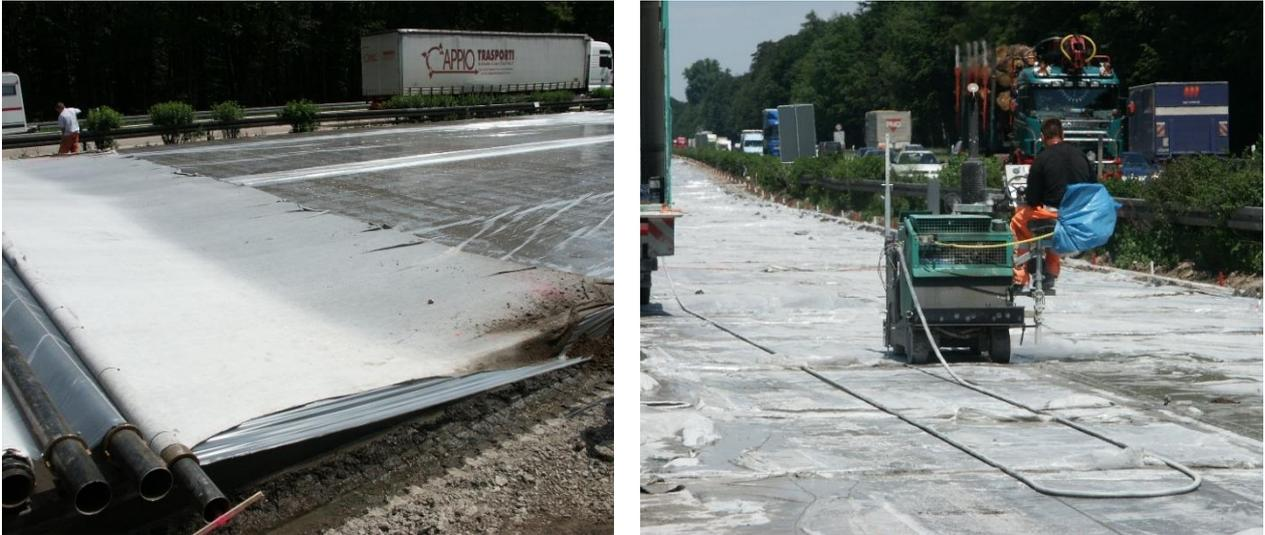
Abb. 3: Aufbringen einer Folie und Fugen bei der Herstellung von Betondecken mit Waschbeton
