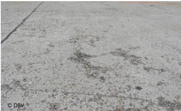
Abb. 3: Abwitterungen und Abplatzungen infolge Frost-Tausalzangriff bei „vertrockneter“ Betonrandzone
