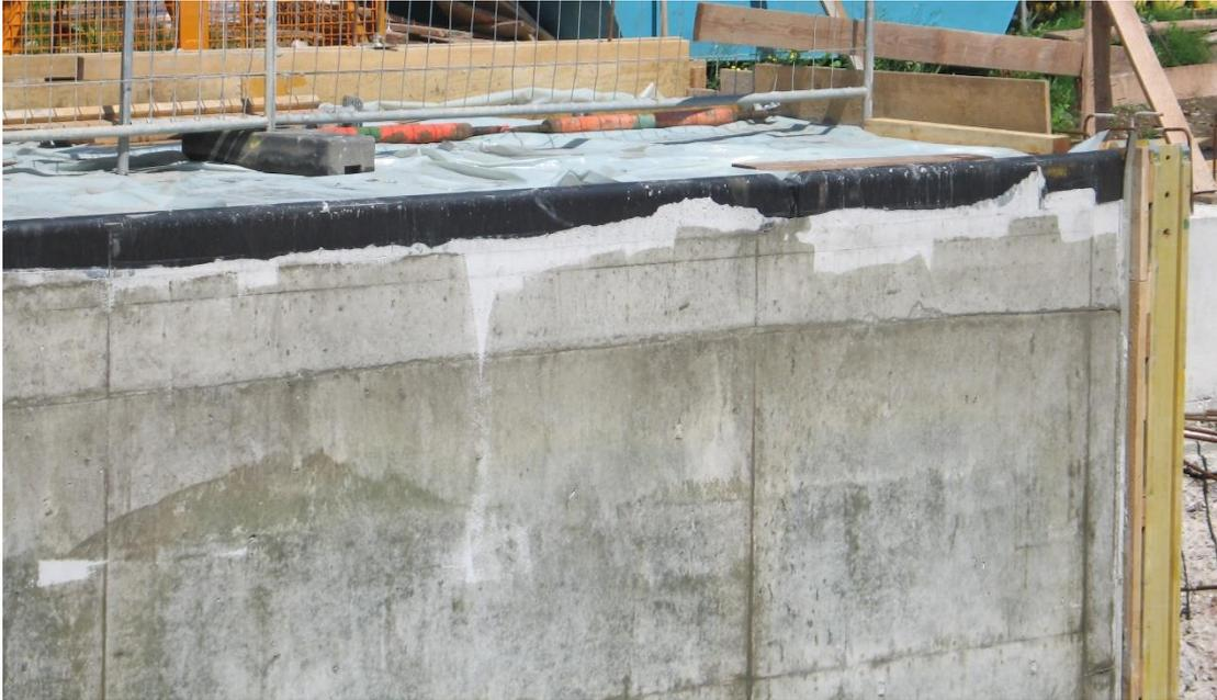
Abb. 4: Unzureichender Auftrag von Nachbehandlungsmittel an einer Schleusenammerwand
