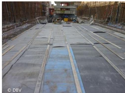
Abb. 6: Betonnachbehandlung mit zusätzlichen Dämmmatten
