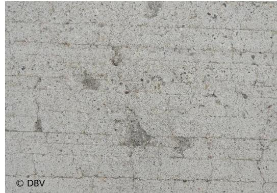
Abb. 4: Oberflächenrisse (netzartig) wegen zu schneller Austrocknung bzw. infolge von Fröhschwinden, (Besenstrich abgefahren)
