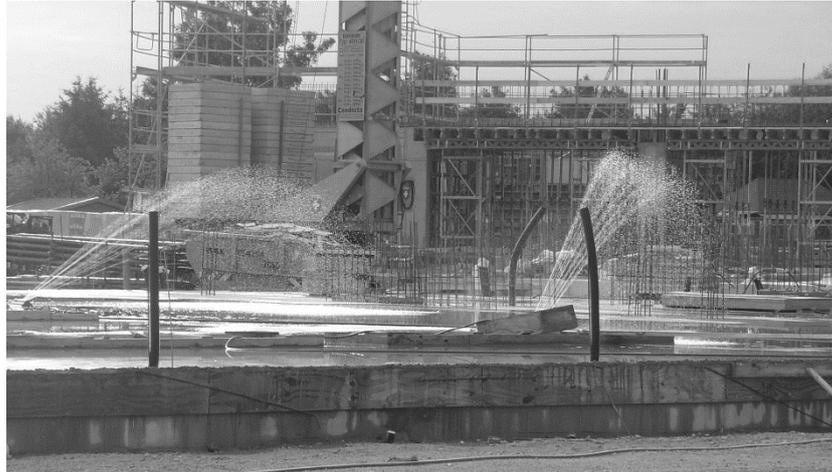
Abb. 2: Beispiel Bewässern einer Bodenplatte
