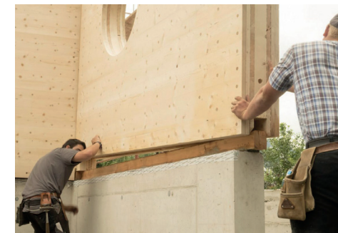
Montage von Wandelementen der Firma Thoma nach dem Nut- und Feder-Prinzip © Thoma Holz GmbH
