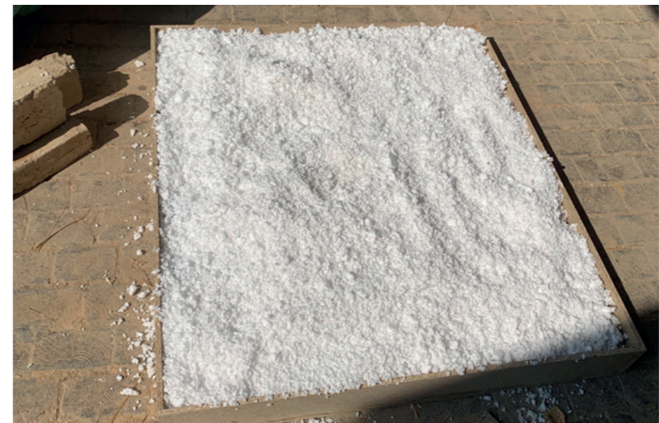
Leerraum zwischen den Flaschen mit EPS-Granulat gefüllt
