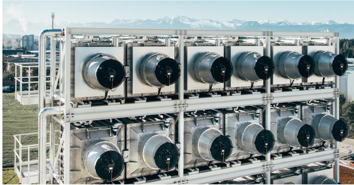
**Abb. 2.2:** Die erste kommerzielle Anlage zur Abtrennung von CO<sub>2</sub> aus der Luft, gebaut vom Schweizer Start-up Climeworks in Hinwil, in der Nähe von Zürich [29]. Die Anlage liefert jährlich ungefähr 900 t CO<sub>2</sub> an ein nahe gelegenes Gewächshaus. Bild entnommen aus [29].
