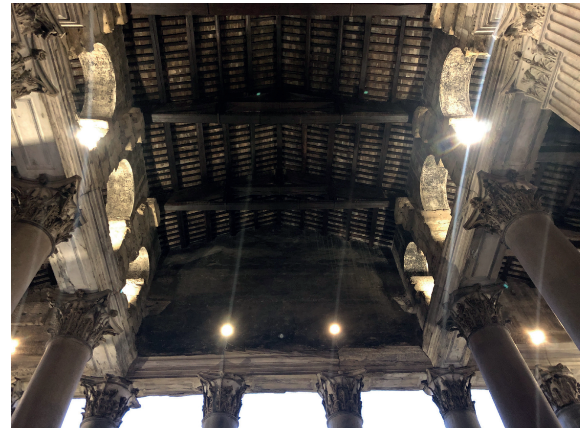
Abb. 10 Rom, Pantheon-Vorhalle, Mittelschiff, Deckenuntersicht. Aufn. F. Klein.
