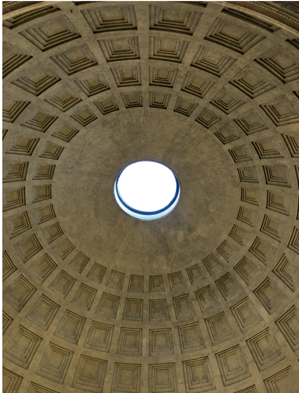
Abb. 11 Rom, Pantheon, Kuppelgewölbe, Innenseite. Aufn. J. Krüger.
