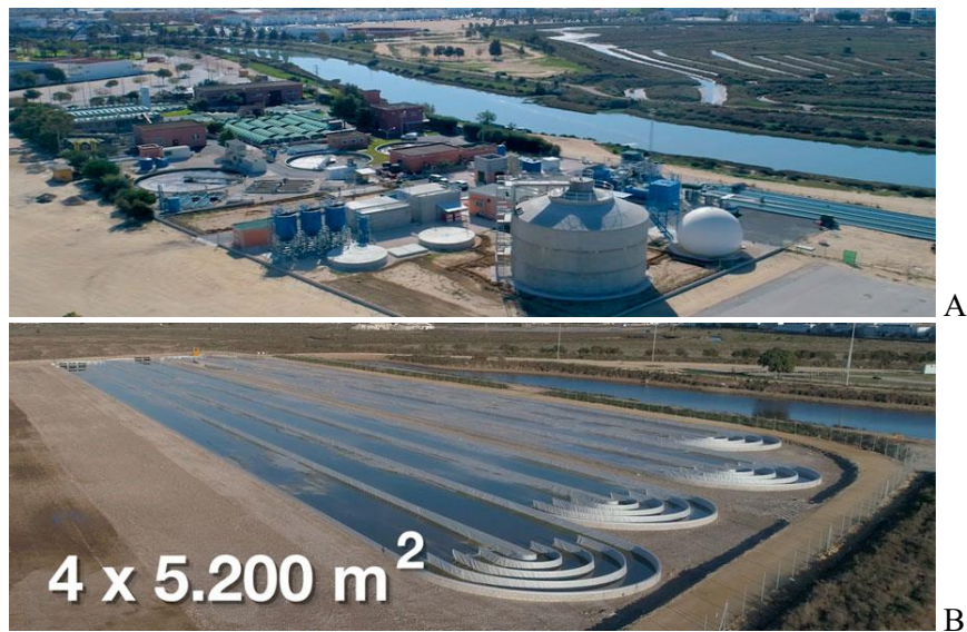
Abbildung 1-13: Demonstrationsanlage des All-gas EU-Projektes (A) zur Biomethanproduktion aus Mikroalgenbiomasse, welche in 2 ha Raceway Ponds (B) in einem kommunalen Abwasser kultiviert werden. Quelle: All-gas EU-Projekt 2023.
