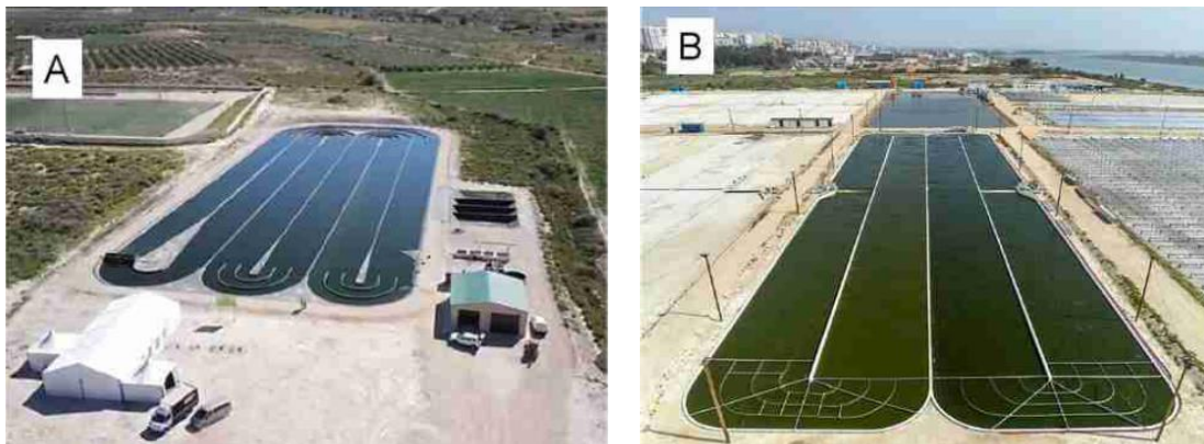
Abbildung 1-10: Offene Reaktorsysteme (A: Raceway Pond, B: Raceway-Kaskadeneinheiten) im großen Maßstab zur Mikroalgenkultivierung. (A) Raceway Pond System ( 15,500 \text{ m}^2 Fläche, 5000 \text{ m}^3 Volumen) für die mikroalgenbasierte Aufarbeitung eines urbanen Abwassers in Agramón, Spanien. (B) Raceway-Kaskadeneinheiten ( 2,500 \text{ m}^2 Fläche, je 100 \text{ m}^3 Volumen) einer großtechnischen Produktionsanlage von Nanochloropsis -Biomasse in Póvoa de Santa Iria in Portugal. Quelle: Masojídek et al. 2023.
