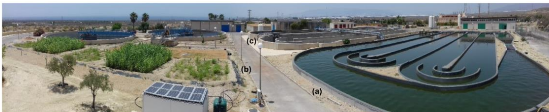
Abbildung 1-11: HRAP (a) und künstlich angelegtes Feuchtbiotop (b) der konventionellen Kläranlage El Toyo in Almería, Spanien (c). Quelle: Saúco et al. 2021.
