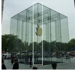
(b) strukturelle Verbindungen im Glasfassadenbau
