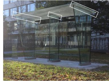
(c) linienförmige Dachlagerung im konstruktiven Glasbau
