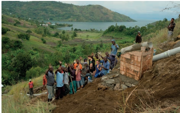
Abb.: Gemeinsam mit den lokalen Arbeitern werden die Fundamente für das Fallrohr betoniert.
