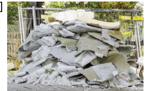
Restkunststoffe Baubereich (WDVS) [5]
