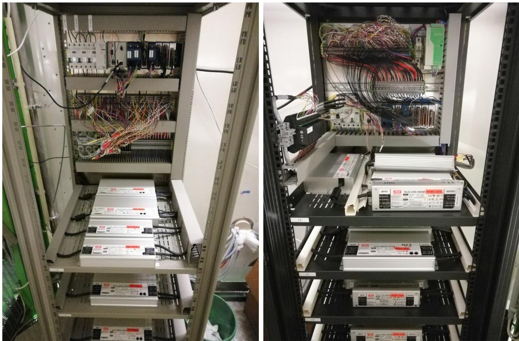
Abbildung A.5: Rack 1 und Rack 2 für die Installation aller Netzteile und Module zur Stromversorgung und Kontrolle der LEDs und und Temperatursensoren.
