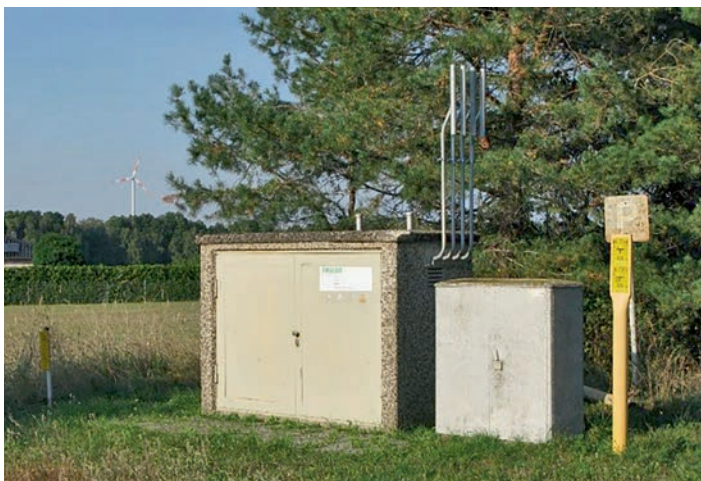
Bild 2.13: Gasdruckregelanlage Schoppsdorf mit einer von zahlreichen Windkraftanlagen in der Region Fläming, Quelle: DVGW-EBI
