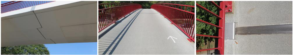
Abbildung 6.6: RWA-Brücke: Sanierte östliche Auflagerkonsole (links), Stützbereich des Randfeldes nach Sanierung (mitte) und neue Übergangskonstruktion am östlichen Ende der Einhängeplatte (rechts) [56]
