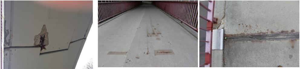
Abbildung 6.5: RWA-Brücke: Korrosionsschaden an der östlichen Auflagerkonsole (links), im Stützbereich des östlichen Randfeldes (mitte) und im Bereich der Übergangskonstruktion (rechts) [56]
