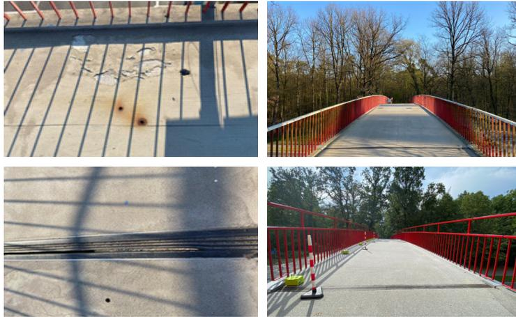
Abbildung 6.8: LA-Brücke: Korrosionsfahnen und beschädigte Beschichtung (links oben), beschädigte Übergangskonstruktion an der nördlichen Auflagerkonsole der Einhängeplatte (links unten), Geländer vor der Ertüchtigungsmaßnahme (rechts oben) und erhöhtes Geländer nach der Ertüchtigungsmaßnahme (rechts unten)
