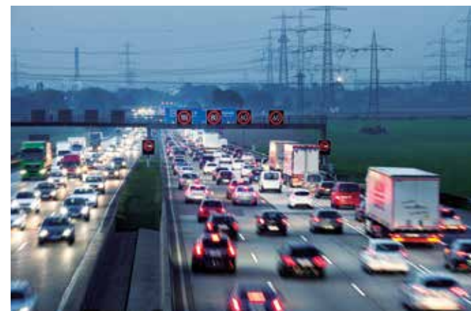
Das wachsende Verkehrsaufkommen auf Autobahnen sorgt für stockenden Verkehr, Staus, Lärm und Abgase. Ein intelligentes Verkehrsmanagement mithilfe von SBA schafft Abhilfe
