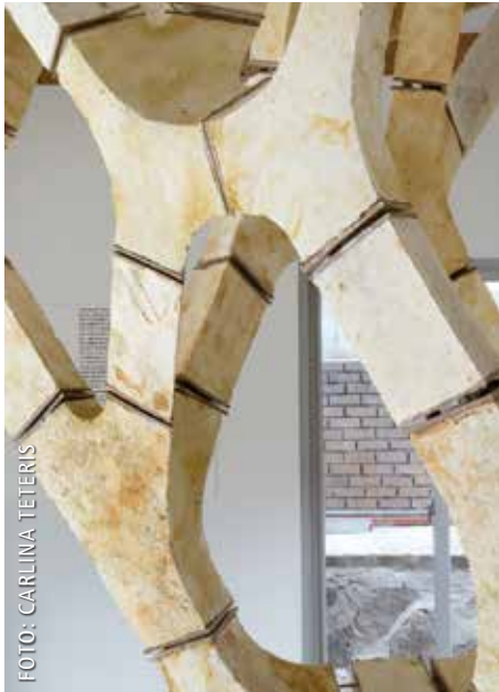
Aus Pilz gewachsene Strukturen (Projekt MycoTree, oben) könnten genauso wie kreislaufgerechte Gebäudekonzepte (Experimentaleinheit UMAR in Dübendorf, unten) Teil des nachhaltigen Bauens der Zukunft sein
