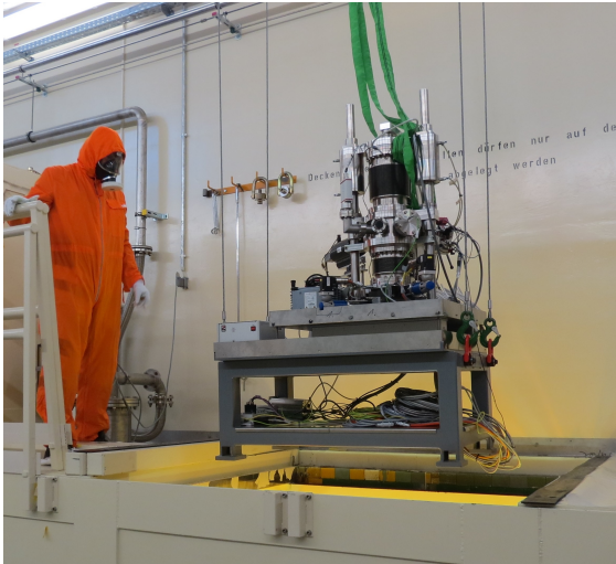
Abbildung 3.7: Anlagenverbund beim Einbau in die Materialprüfzelle über die Deckenöffnung; zur Sicherung und Überwachung ist ein Mitarbeiter direkt an der Zellenöffnung positioniert
