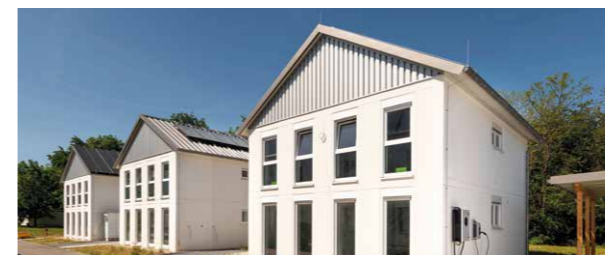
Abb. 3: Im Smart Energy System Control Laboratory (SECL) werden repräsentativ für den realen Energieverbund der Zukunft die wichtigsten energietechnischen Anlagen mithilfe einer Sammelschienenmatrix flexibel verschaltet, damit experimentelle Konfigurationen rasch verändert werden können.
