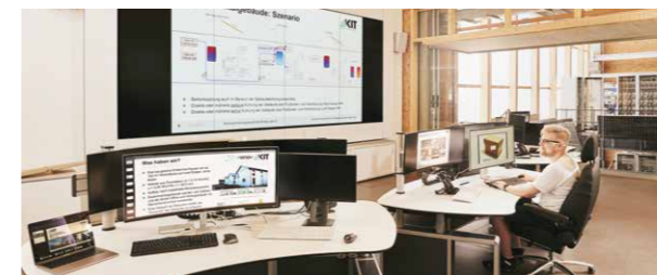
Abb. 5: Im Control, Monitoring and Visualization Center (CMVC) des Energy Lab 2.0 werden die Softwaretools für eine Leitwarte der zukünftigen Energienetze entwickelt.
