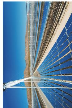
Abbildung 1: Absorberrohr und planare Spiegel, Quelle: ebl
