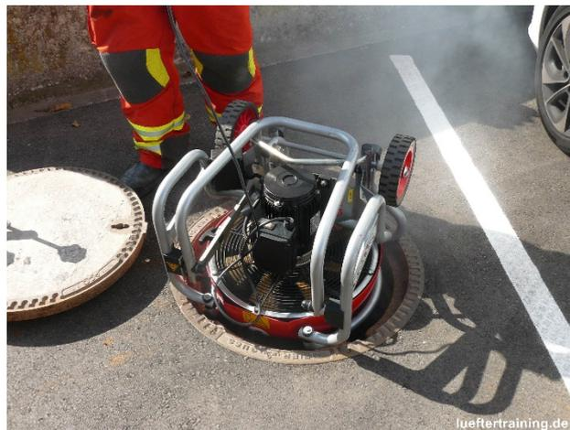
Abb. 4: Belüftung von Kanalanlagen (www.lueftertraining.de 2020)
