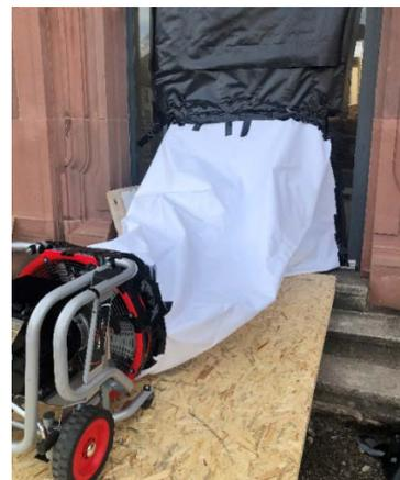
Abb. 53: Lüfter mit Lutte. Die Lutte hat einen runden Einlass mit ca. 500mm Durchmesser und einen quadratischen Auslass mit 1m x 1m.
