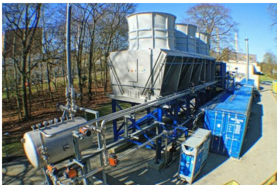
Fig. 3:Propane tank und Condenser
