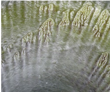
Slag layer on cooling screen
