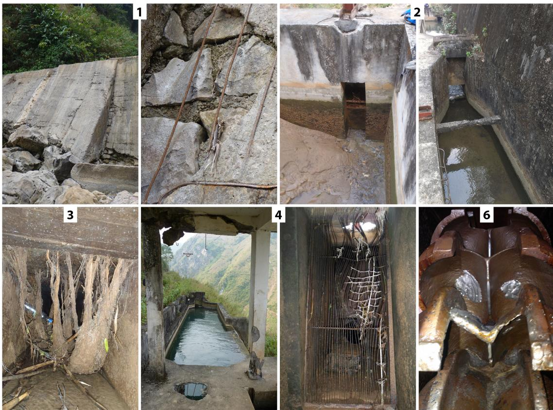
Abbildung 5.6: Baulicher Zustand der Systemkomponenten Wehr (1), Sandfang (2), Triebwasserkanal (3), Einlaufbecken (4) und Maschinentechnik (6)
