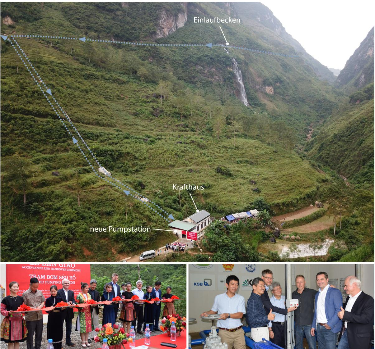
Abbildung 6.16: Wasserkraftwerk mit Bypass-System (oben), Eröffnungsfeier und symbolische Inbetriebnahme der Fördermodule (unten)
