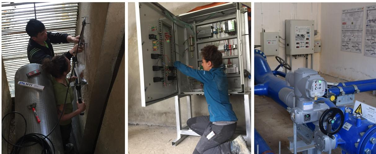
Abbildung 6.6: Installation der Sonden am Einlaufbecken (links) und des Schaltschrankes (mitte) sowie Fertigstellung des Alarm- und Monitoringsystems (rechts)
