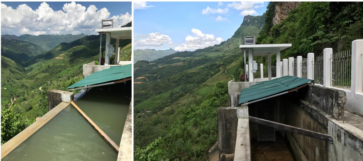
Abbildung 6.9: Installation des Balkens (links) und Einsatz des Balkens zur Abführung von Treibgut (rechts)
