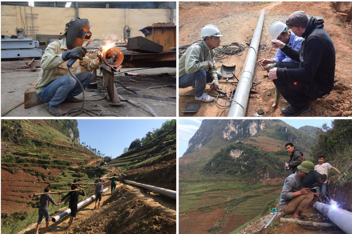
Abbildung 6.3: Bauliche Umsetzung der Förderleitung sowie Qualitätssicherung der Schweißarbeiten durch die Herstellung eines Schweißprobestücks und Fach-Schulungen
