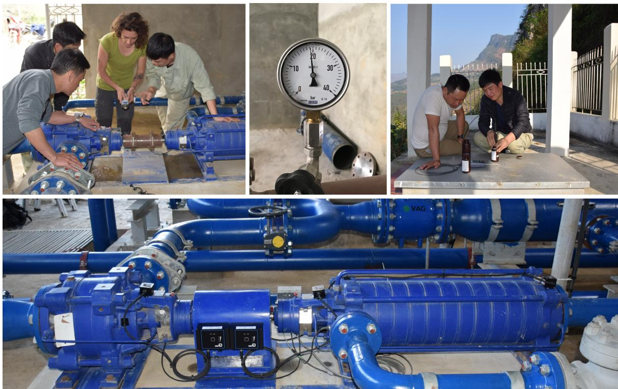
Abbildung 6.11: Überwachung der Drehzahl, des Vordrucks und der Trübung (oben), Installation des KSB Guard System (Online-Anbindung) (unten)
