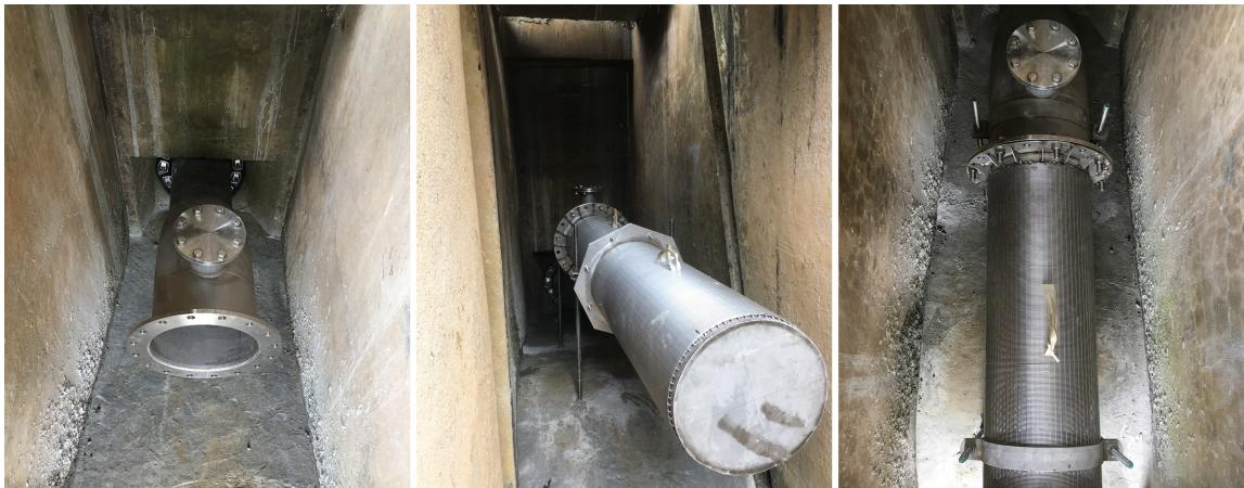
Abbildung 6.8: Filterrohr und Etage im eingebauten Zustand
