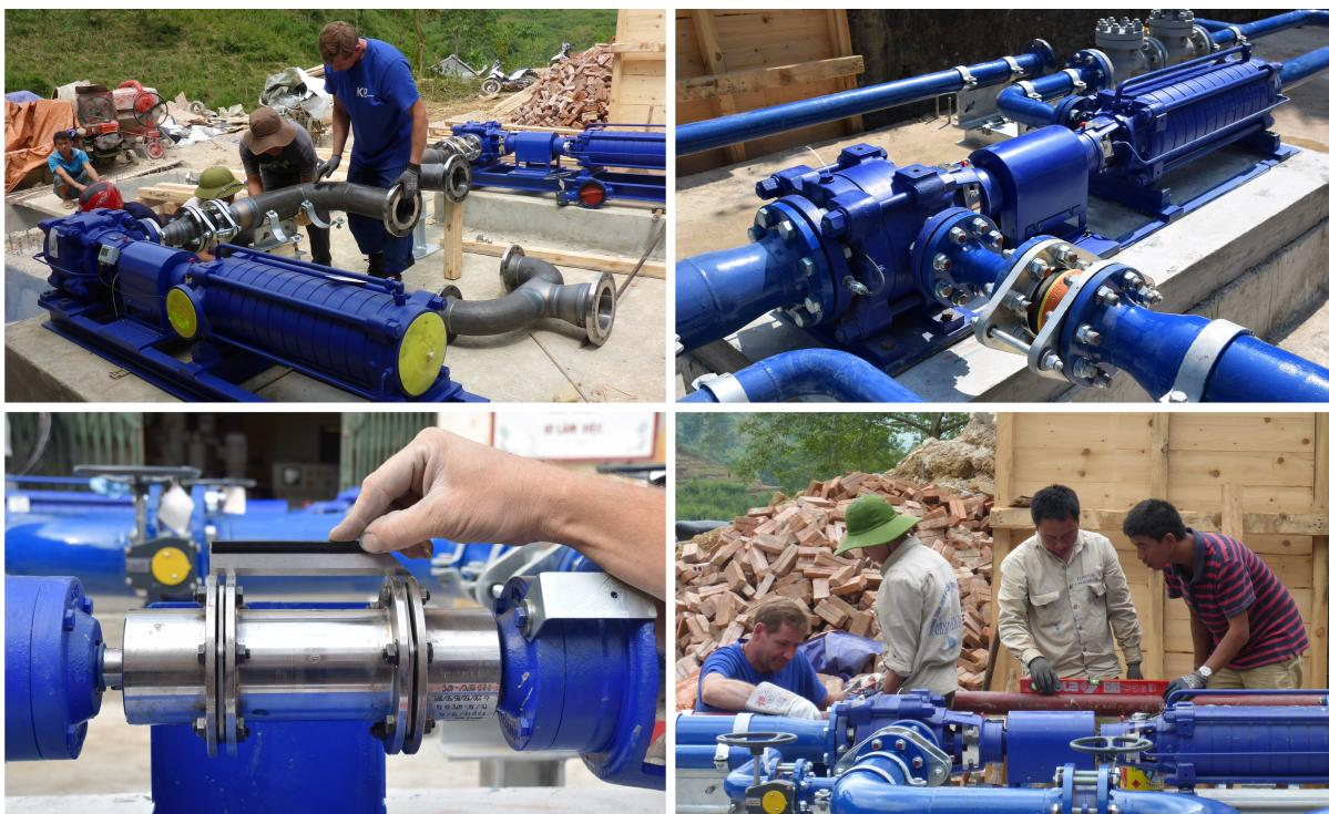
Abbildung 6.5: Installation des Förderungssystems mit hochpräziser Ausrichtung für einen spannungsfreien Zusammenschluss aller Komponenten
