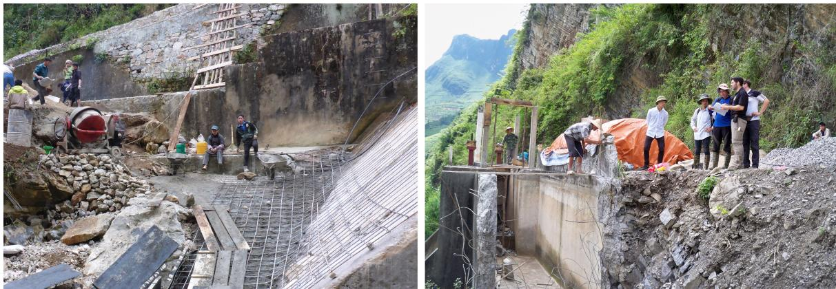
Abbildung 6.4: Überwachung der Betonbauarbeiten am Wehr (links) und Einlaufbecken (rechts)
