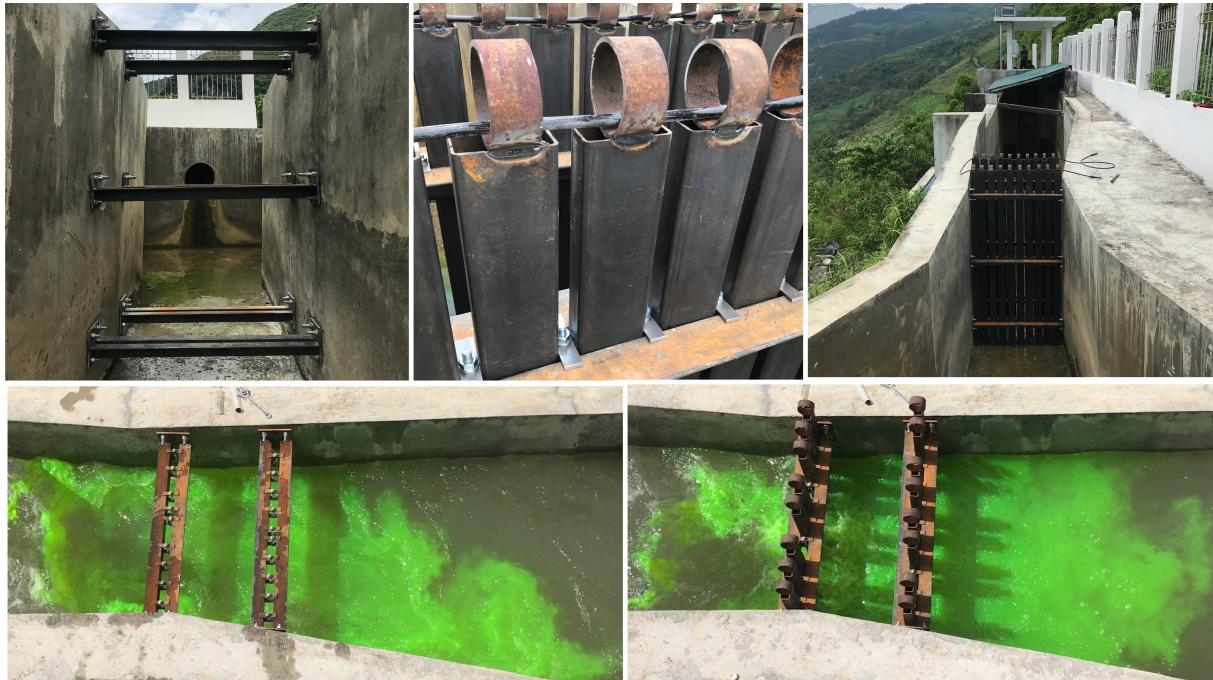
Abbildung 6.7: Installation der Lamellen (oben) und Strömungsbild mit und ohne eingesetzten Lamellen (unten)
