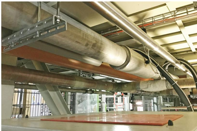
**Abb. 9** Supraleitende 20-kA-Stromschiene in einer Chlorelektrolyse-Anlage in Ludwigshafen (Foto: Vision Electric SuperConductors GmbH).
