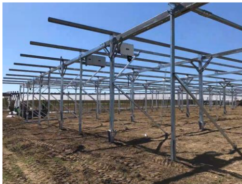
Abbildung 4.1: e100 Neubau Agrarphotovoltaikanlage – Projekt APV
