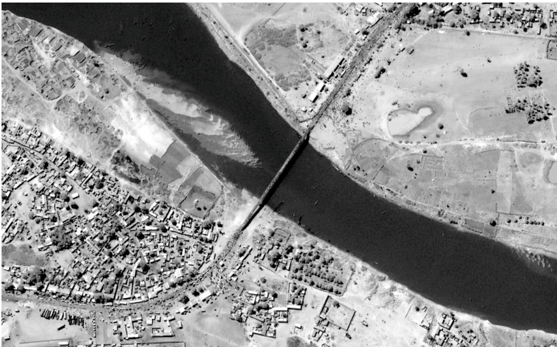
Abb. 3.13 WorldView-1-Aufnahme (Bodenauflösung 50 Zentimeter)
