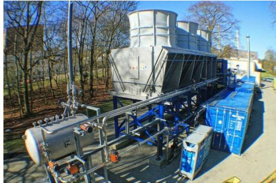
Fig. 3:Propane tank und Condenser
