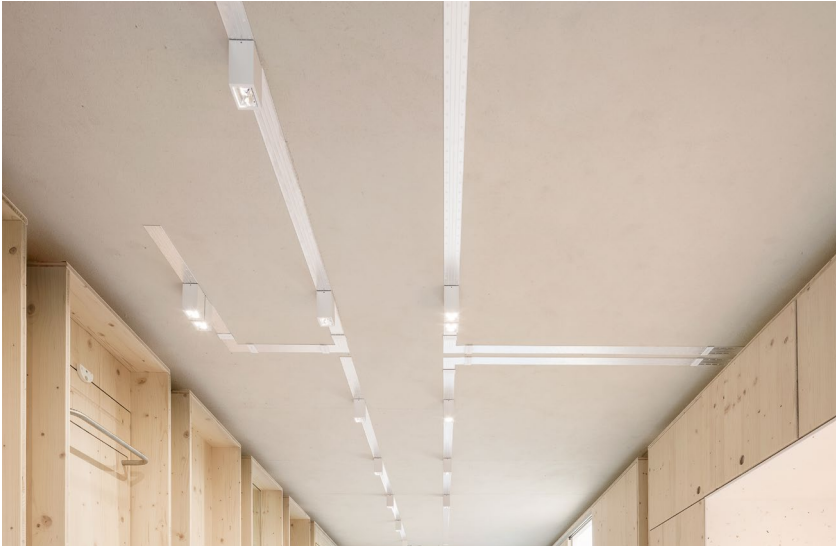
Abb. 61: Aufputz Elektroinstallation – Foto: Nicolai Rapp
