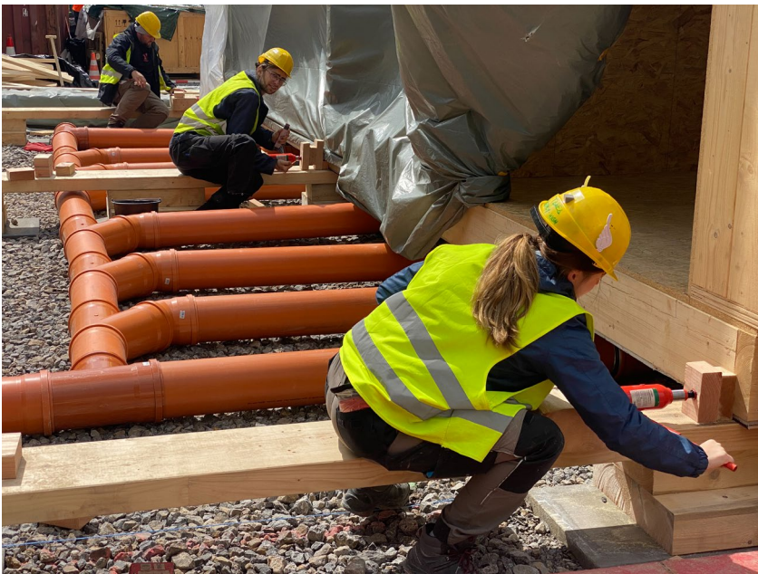
Abb. 125: Verlegung Bodenrohre
