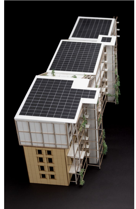
Abb. 135: Intensive Nutzung von Solarenergie an der Aufstockung
