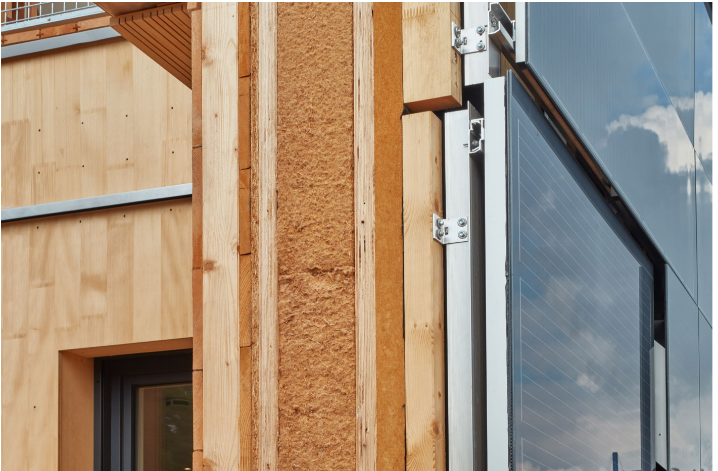
Abb. 151: Wandaufbau der House Demonstration Unit – Foto: Sigurd Steinprinz | BU Wuppertal
