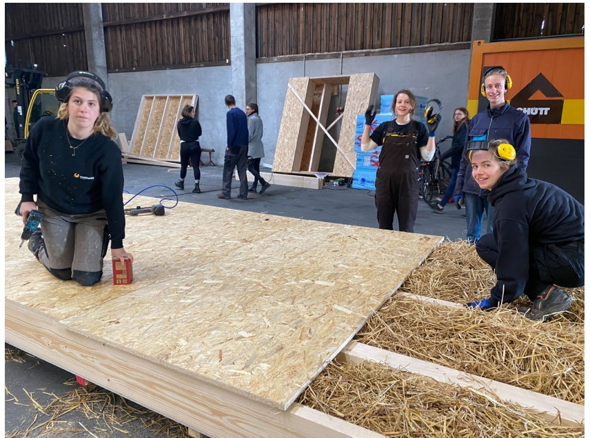
Abb. 104: Boden mit Stroh herstellen
