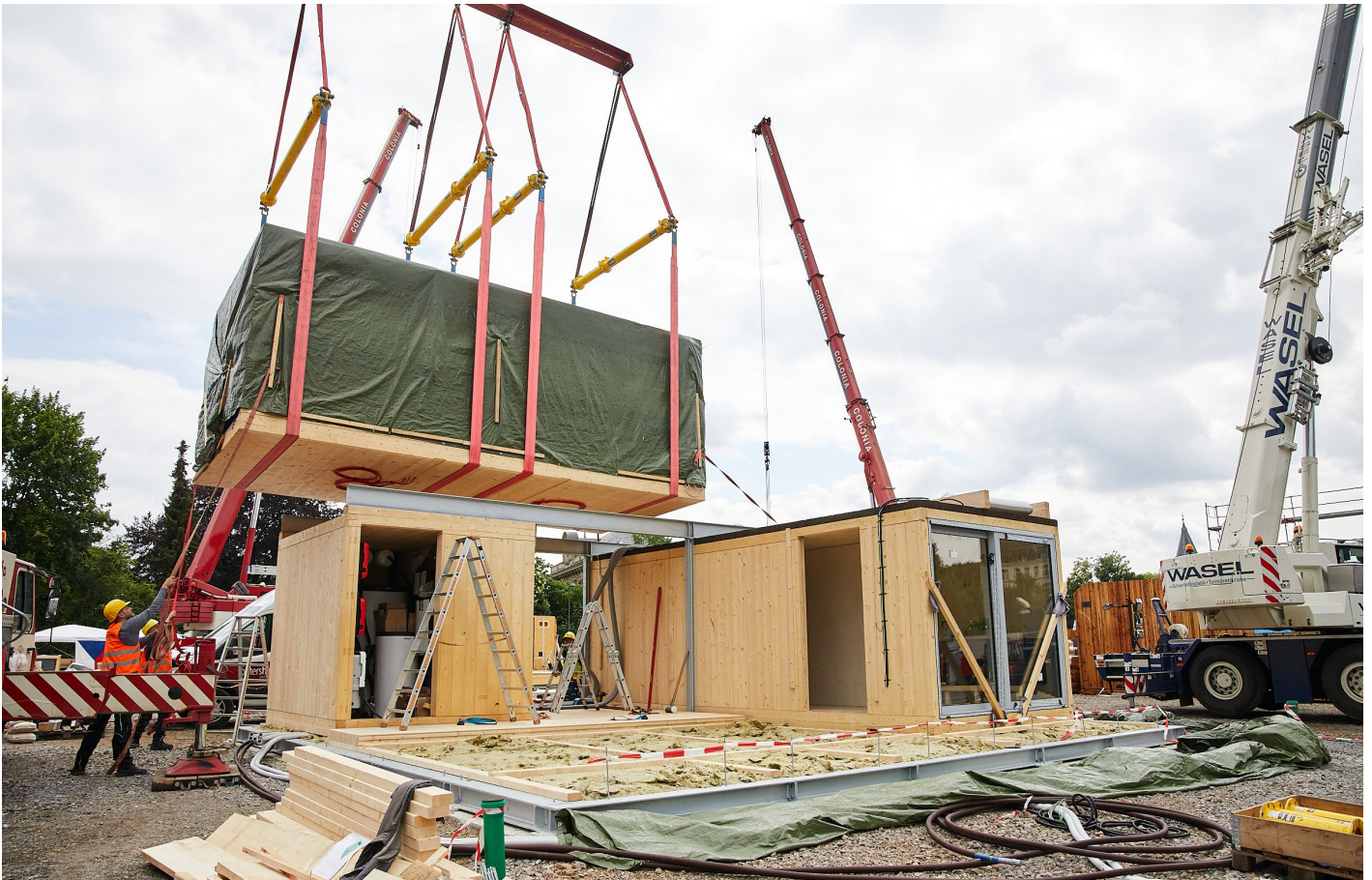
Abb. 217: Versatz des oberen Vollholzmoduls – Foto: Team MIMO
