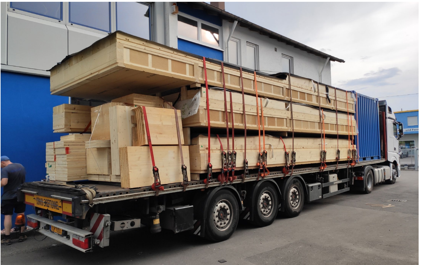
Abb. 308: Beladener LKW mit vorgefertigten Bodenelementen und Montagezubehör
