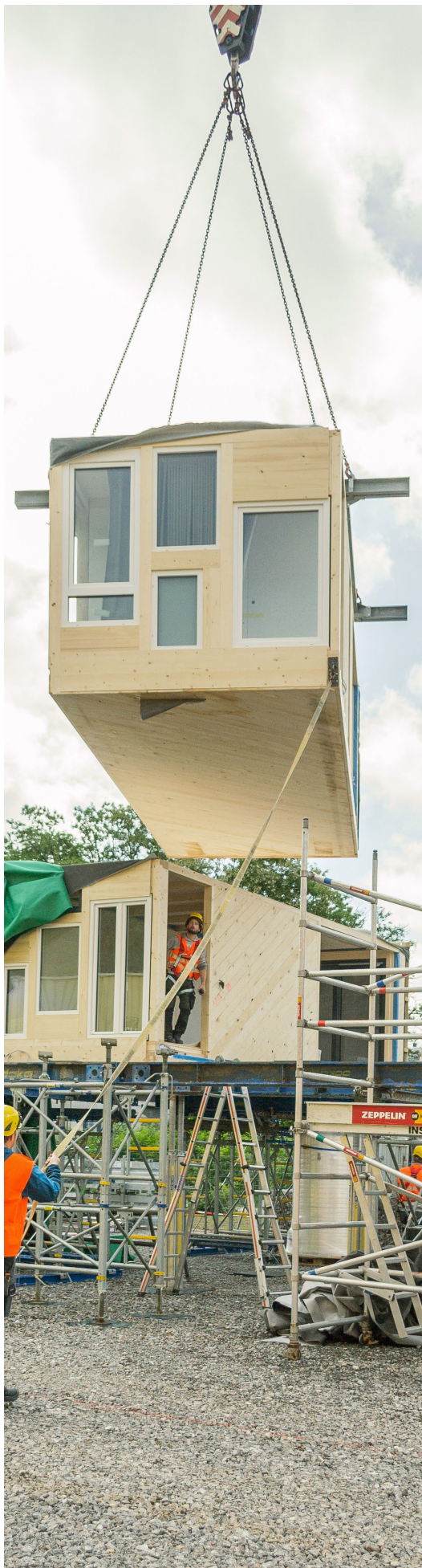
Abb. 265: Aufbau der Module der HDU in Wuppertal
