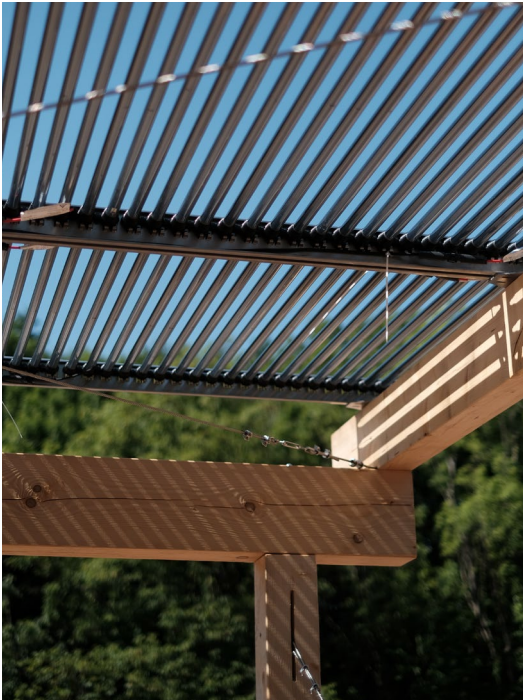
Abb. 309: Glasröhren mit Dünnschicht-Zellen als semi-transparente Photovoltaik-Module
