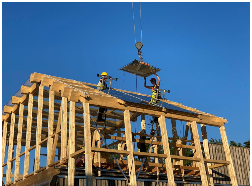
Abb. 118: Montage der Photovoltaik
