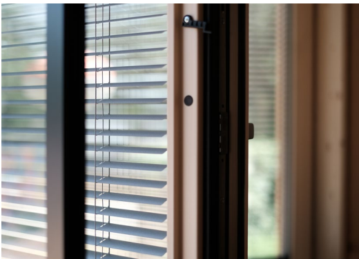
Abb. 314: Verbundfenster mit integriertem Sonnenschutz. Der Sonnenschutz und der Holzrahmen innen sind gegen Witterungseinflüsse und Wind durch die äußere Scheibe geschützt
