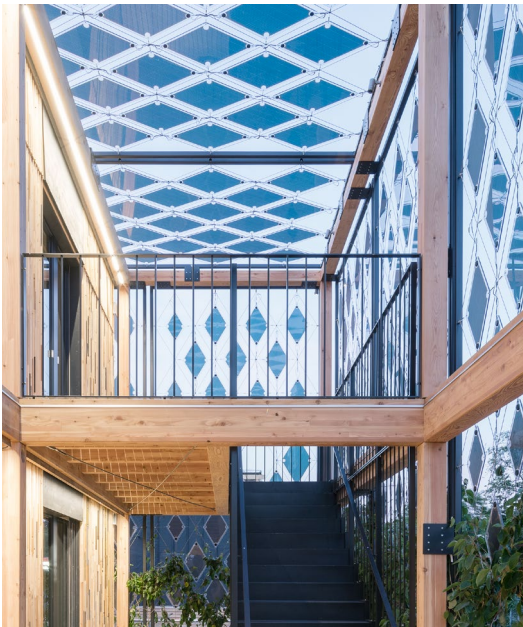
Abb. 70: OPV-Fassade entlang des Holzgrids Foto: Nicolai Rapp
