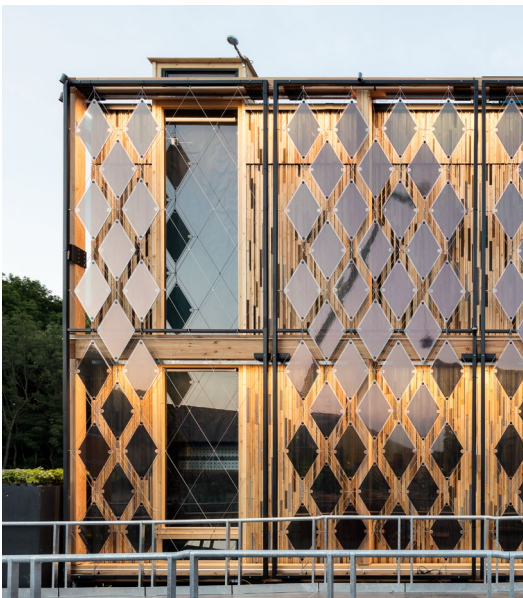
Abb. 71: Westseite mit Solarkamin Foto: Nicolai Rapp
