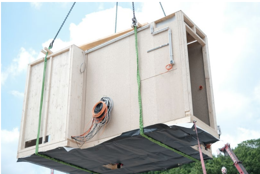
Abb. 307: Vorinstalliertes Raummodul für die Haustechnik
