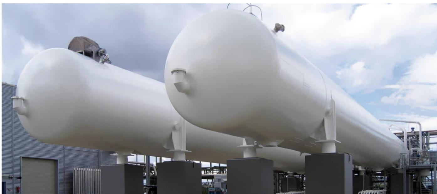
Abbildung 5.6: Zylindrische LH<sub>2</sub>-Tanks am Wasserstoffverflüssiger in Leuna, Deutschland. Quelle: Linde
