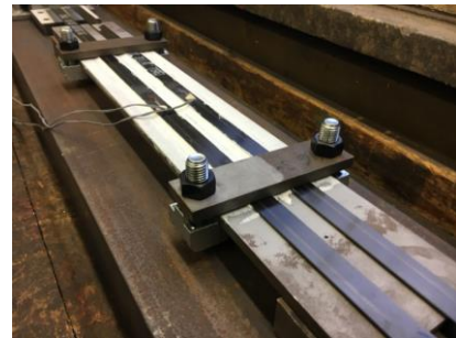
6. Anbringen der geschraubten Endverankerungsbleche
