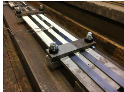
6. Anbringen der geschraubten Endverankerungsbleche
