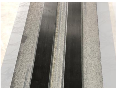
5. Applizierte Lamellen mit seitlich ver- rundeten Klebschichten
