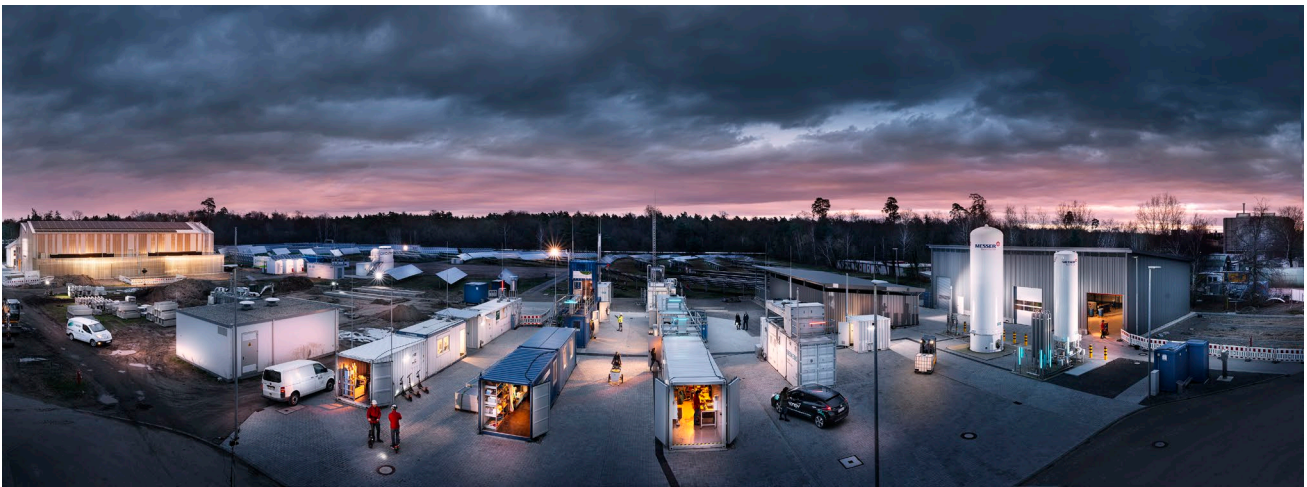
Abbildung 1: Das Energy Lab 2.0 der Karlsruher Institut für Technologie KIT als Pilotanlage zur e-Fuel Synthese
