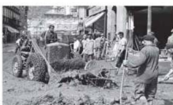
Schweres Gerät: Aufräumarbeiten in der Hauptstraße.
