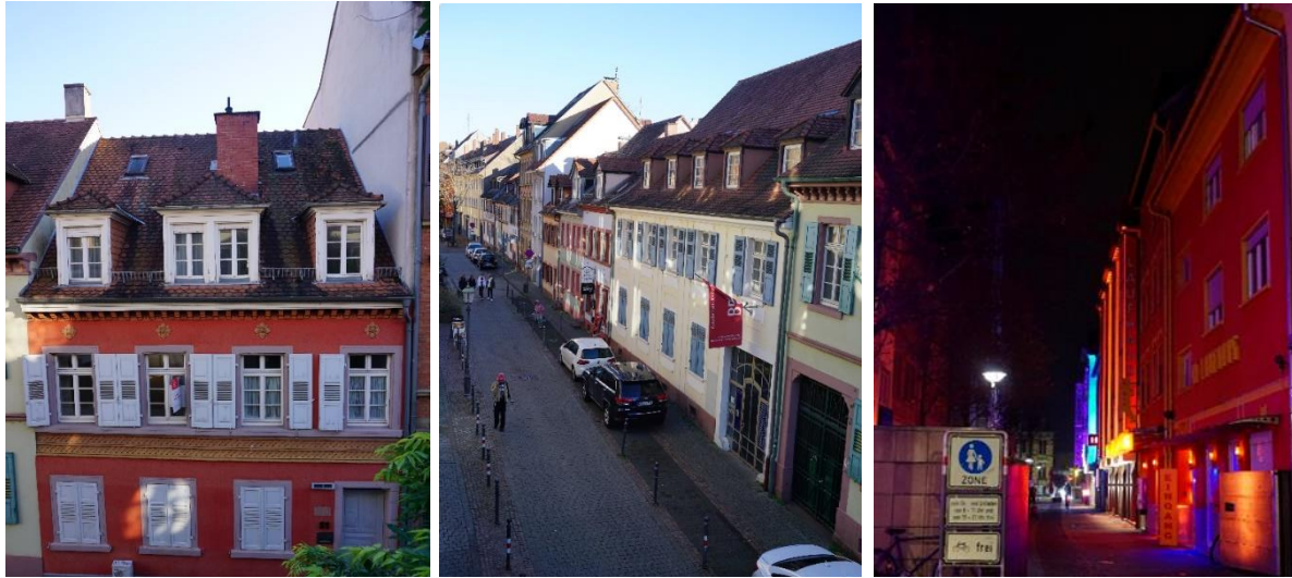
Abbildung 27: Objektsanierungen im Dörfle und Rotlichtviertel („Brunnenstraße“)
