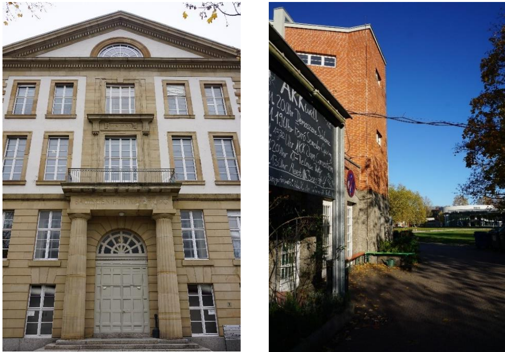
Abbildung 10: Blick auf das alte Bauingenieurgebäude (10.81) (links) und Blick vom AKK auf das Forum, im Hintergrund das Gebäude des Audimax (rechts)
