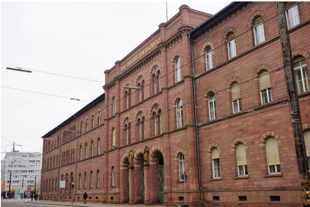
Abbildung 8: Ehemaliges Hauptgebäude des Polytechnikums und der Universität
