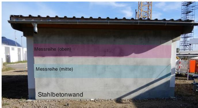
Abb. 7.11: Die Stahlbetonwand ist in Sandwichausführung gefertigt und besteht aus einem dreischichtigen Aufbau: Stahlbeton–Dämmschicht–Stahlbeton.
